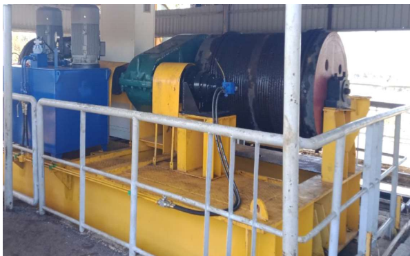
Hình 11. Thay thế tời thủy lực lực nâng 110 tấn sử dụng hộp giảm tốc bánh răng hành tinh tại thủy điện Sê San 4 (Gia Lai)
