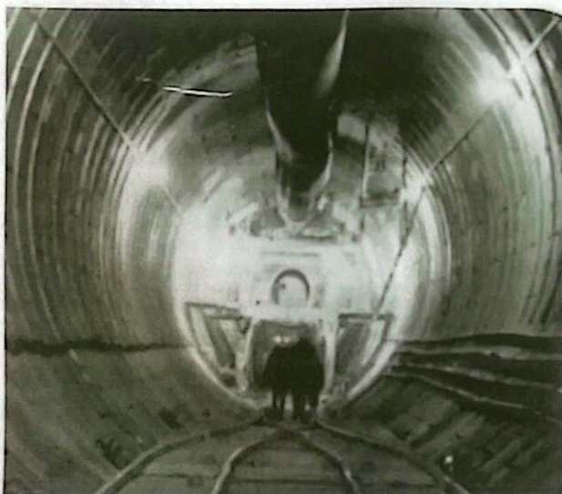
a) Vỏ chống đúc sẵn cho đường hầm xây dựng dưới sông St. Clair giữa Sarnia, Ontario và Port Huron, Michigan, Hoa Kỳ [3]
