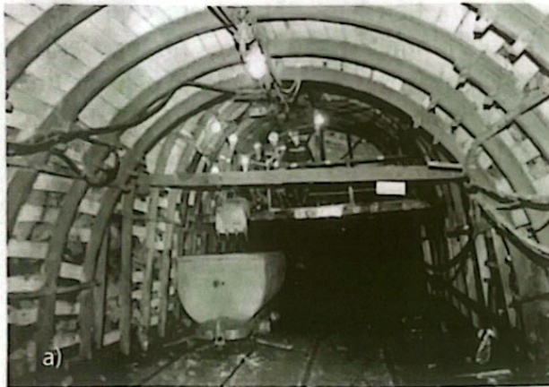
Hình 2. Hình ảnh tấm chèn bê tông cốt thép sử dụng thực tế (a); mô hình tính tấm chèn (b); sơ đồ tải trọng đất đá tác dụng lên tấm chèn (c)
