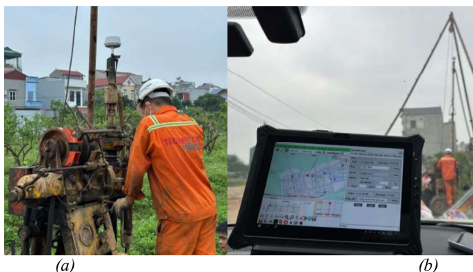
Hình 5. Thiết lập thực nghiệm hiện trường (a) và kết nối thiết bị (b)
