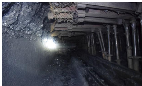
Hình 5. Vì chống không chống sát mặt gương tại lò chợ I-6-2
