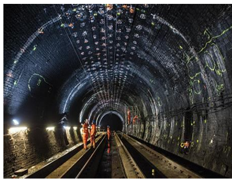
Hình 9. Giải pháp bơm ép vữa gia cường vỏ hầm
