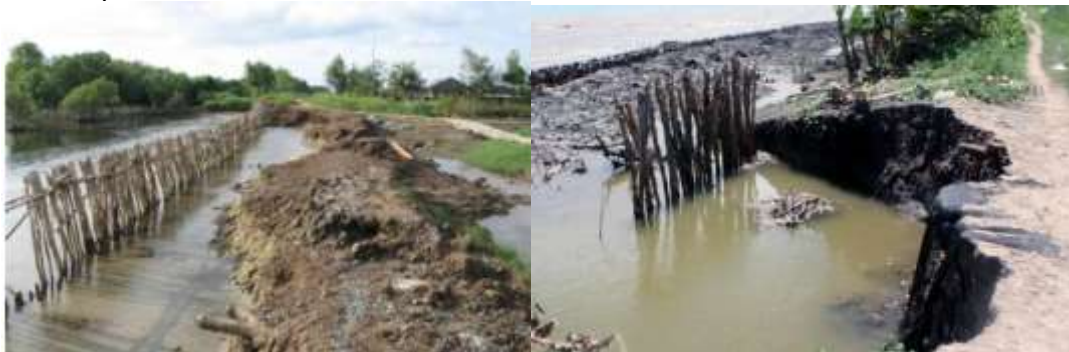
Hình 5. Đê biển bị vỡ để lộ vật liệu đắp đê không đồng nhất
