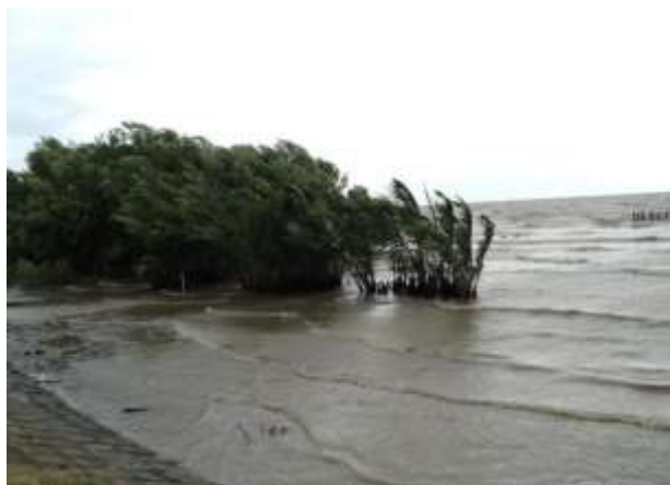
Hình 3. Sạt lở đê đoạn đê đi qua thành phố Rạch Giá
