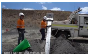
b, Thả túi xuống lỗ khoan
