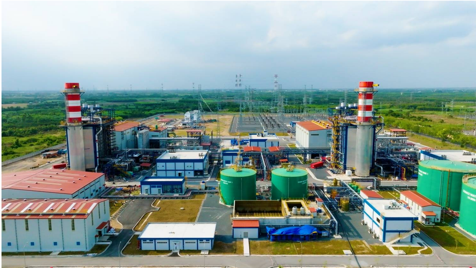
Nhà máy điện Nhon Trạch 3&4 sử dụng tua-bin khí 9HA.02 hỗ trợ tích hợp năng lượng tái tạo.
