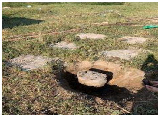
(b) Cọc sau 10 ngày thi công
