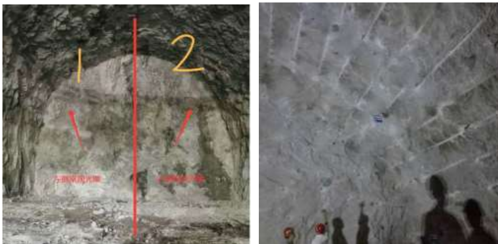
Hình 5. Sử dụng ống tập trung năng lượng sau khi nổ mìn [11]
