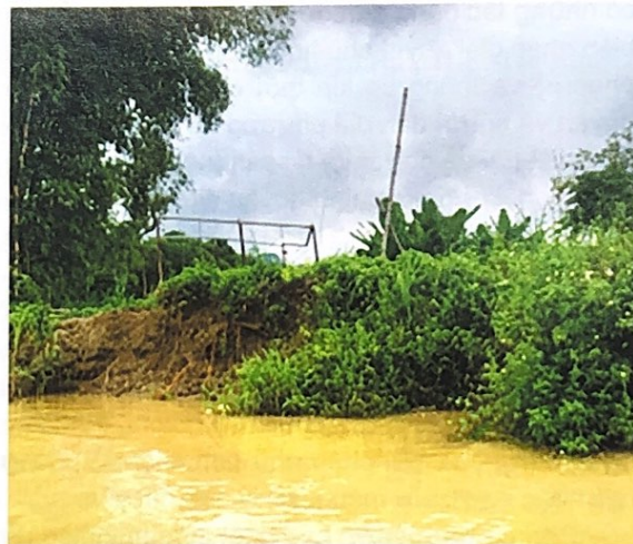
H.4. Sạt lở bờ sông
