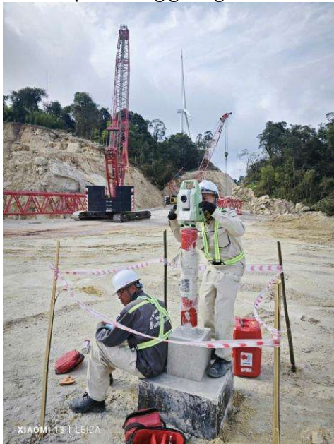
Hình 8. Máy toàn đạc điện tử Leica TM30-R1000 đo đạc trụ điện gió (ảnh Tạ Minh Sơn, Đỗ Văn Mão)
