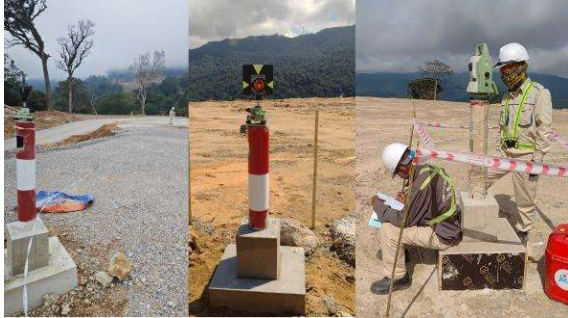
Hình 5. Xây dựng mốc và chuẩn bị máy thiết bị đo (ảnh Tạ Minh Sơn, Đỗ Văn Mão)
