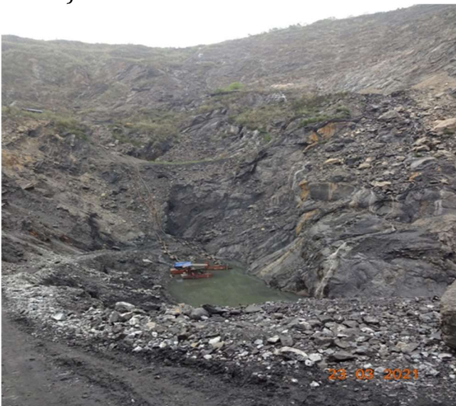
Hình 1. Hiện trạng đáy moong -230m và trạm bơm tháo khô (a) và khu vực đánh giá có khối trữ lượng 3-111 (b), mỏ than Phấn Mễ (2021)
