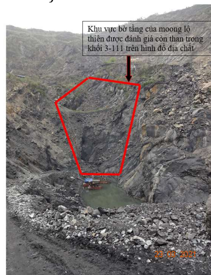
Hình 1. Hiện trạng đáy moong -230m và trạm bơm tháo khô (a) và khu vực đánh giá có khối trữ lượng 3-111 (b), mỏ than Phấn Mễ (2021)
