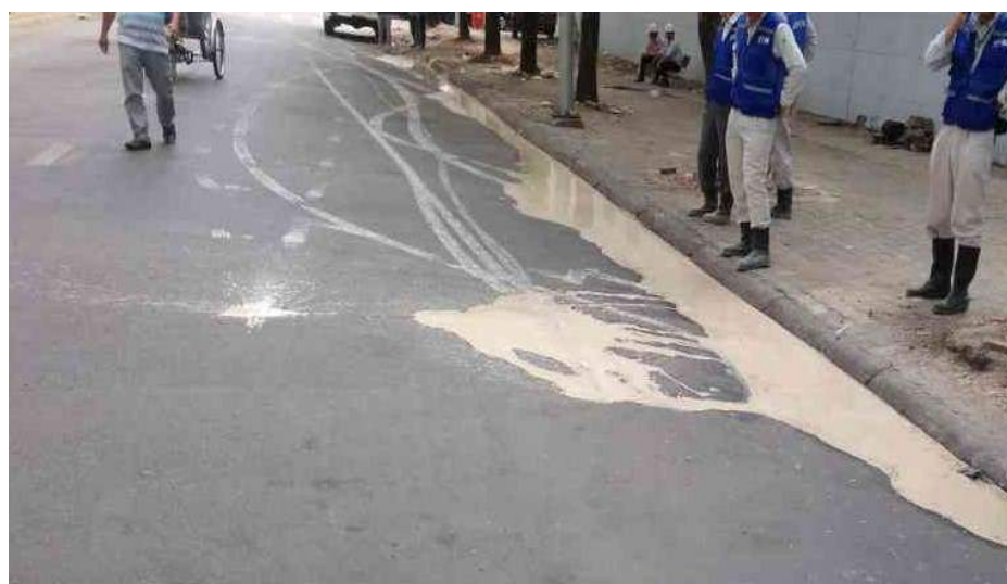
Hình 8. Đẩy trôi tại Km1+500 dự án tuyến tàu điện ngầm số 1 TP. Hồ Chí Minh
