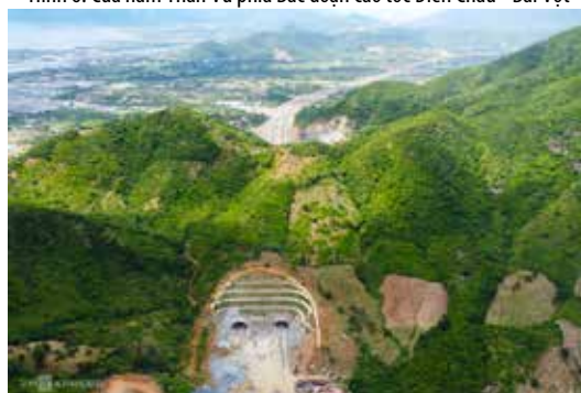
Hình 8. Cửa hầm Dốc Sạn phía Bắc đoạn cao tốc Nha Trang - Cam Lâm
