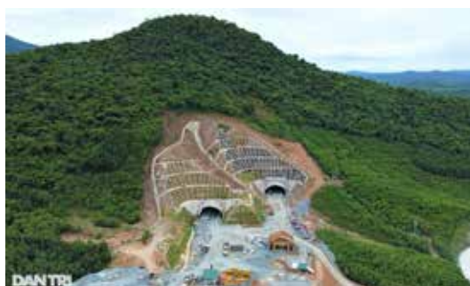
Hình 10. Cửa hầm Đèo Bụt đoạn cao tốc Vũng Áng - Bùng
