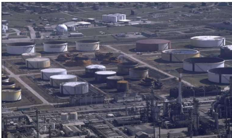
Hình 5. Bể chứa bị phá hủy tại khu vực nhà máy lọc dầu Tupras (Erdik, 2000).
