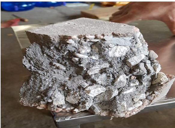
Hình 8. Cấu trúc bên trong của mẫu bê tông geopolymer sau khi phá hủy ở 900°C
