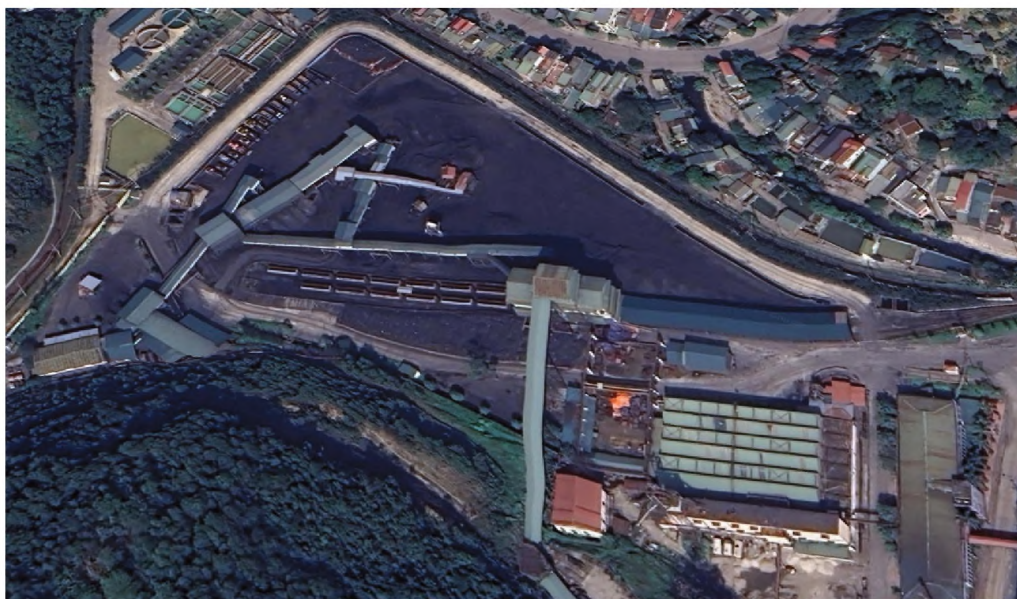
Hình 3. Các công trình kho bãi trên mặt bằng mỏ than Mông Dương
