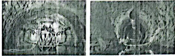
Hình 1.9. Kết quả nổ mìn để lại vết cần khoan trên biên hầm, nổ mìn tại Thụy Điển
