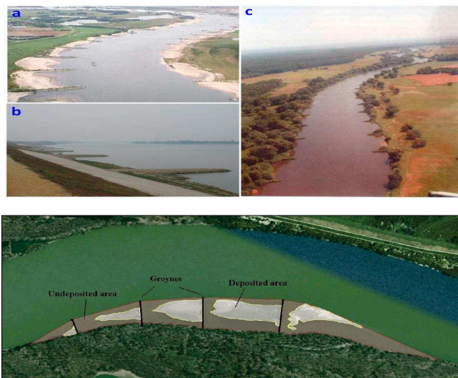
Hình 6. Nguyên tắc chỉnh trị bằng giải pháp mỏ hàn
