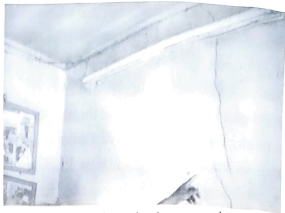
Hình 2. Nhà nứt do việc nổ mìn từ mỏ đá Hồng Phong I, xã Phú Xá (Cao Lộc - Lạng Sơn)
