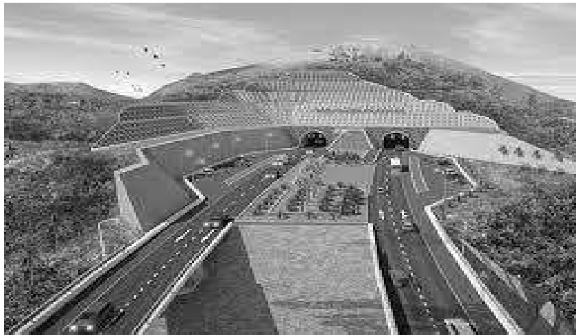
Hình 1. Đường hầm Đèo Cả, Phú Yên, Việt Nam (Chi T.N và nnk, 2022)
