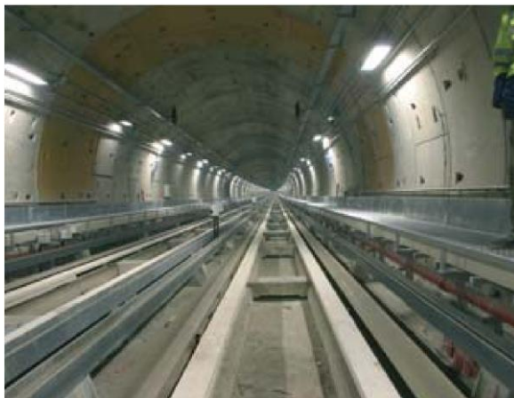
Hình 3.12. Các đường hầm của hệ thống tàu điện ngầm Turin được khoan bằng máy TBM và được gia cố bằng lớp lót dạng phân đoạn.
