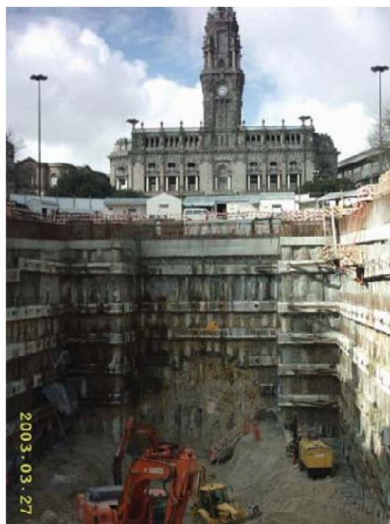
Hình 3.7. Nhà ga Aliados trước khi máy khoan hầm TBM xuyên thủng tường
