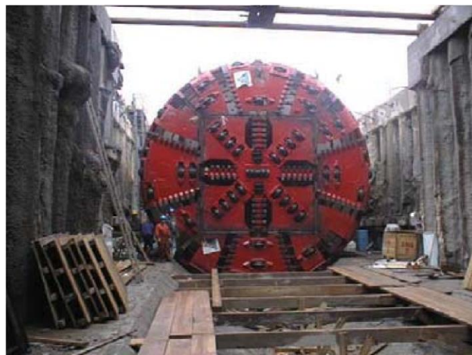
Hình 3.9. Đầu máy cắt của máy khoan hầm Herrenknecht TBM đầu tiên tại Porto
