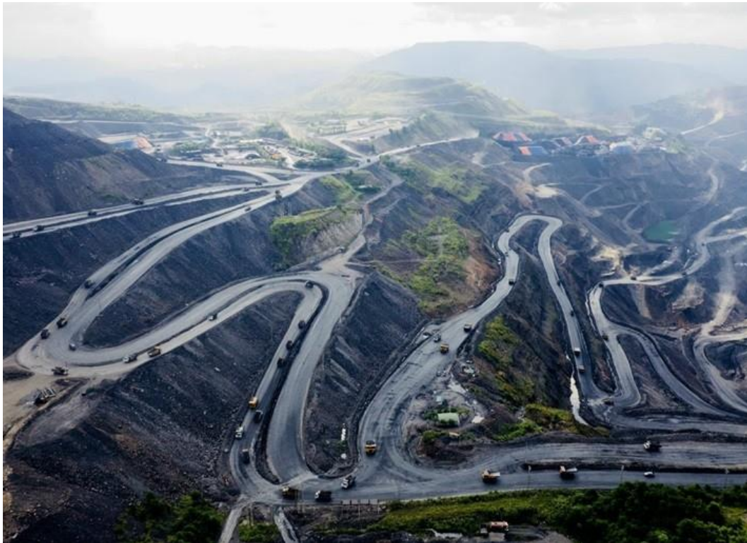
Hình 1.4. Công trường khai thác than lộ thiên mỏ than Cao Sơn
