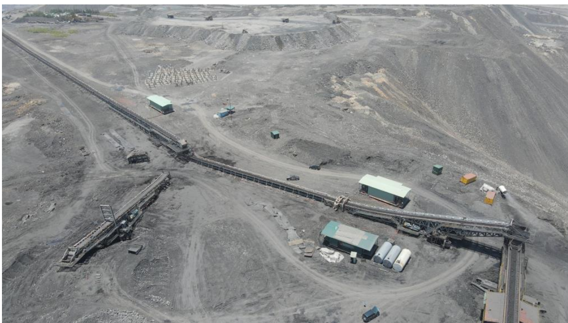
Hình 2.7. Hệ thống băng tải đá trên mặt bằng +300 m của BT Bàng Nâu [21]
