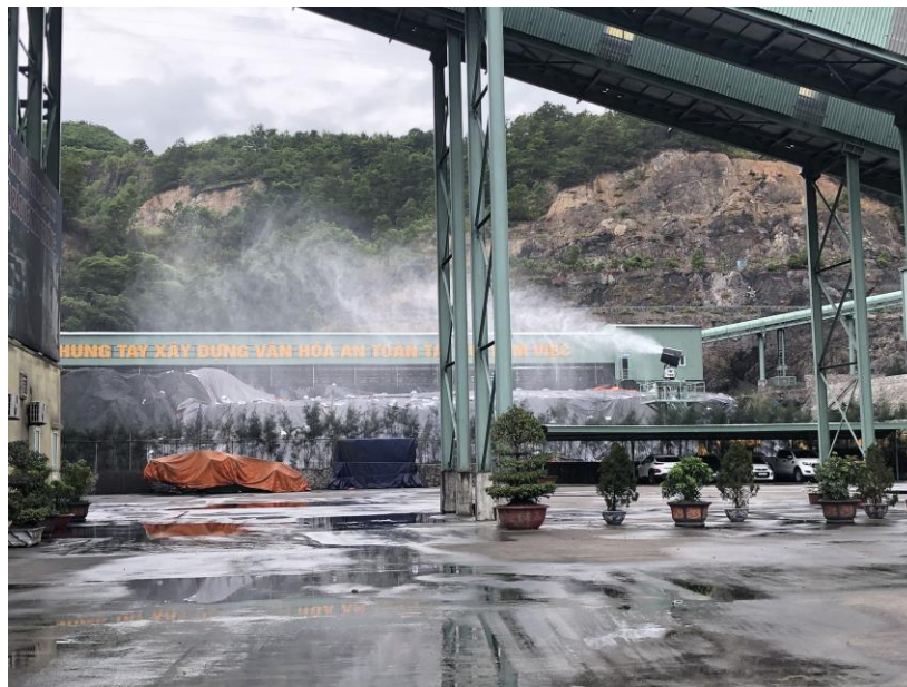
Hình 3.3. Hệ thống phun sương cao áp và hệ thống băng tải giúp giảm thiểu bụi
