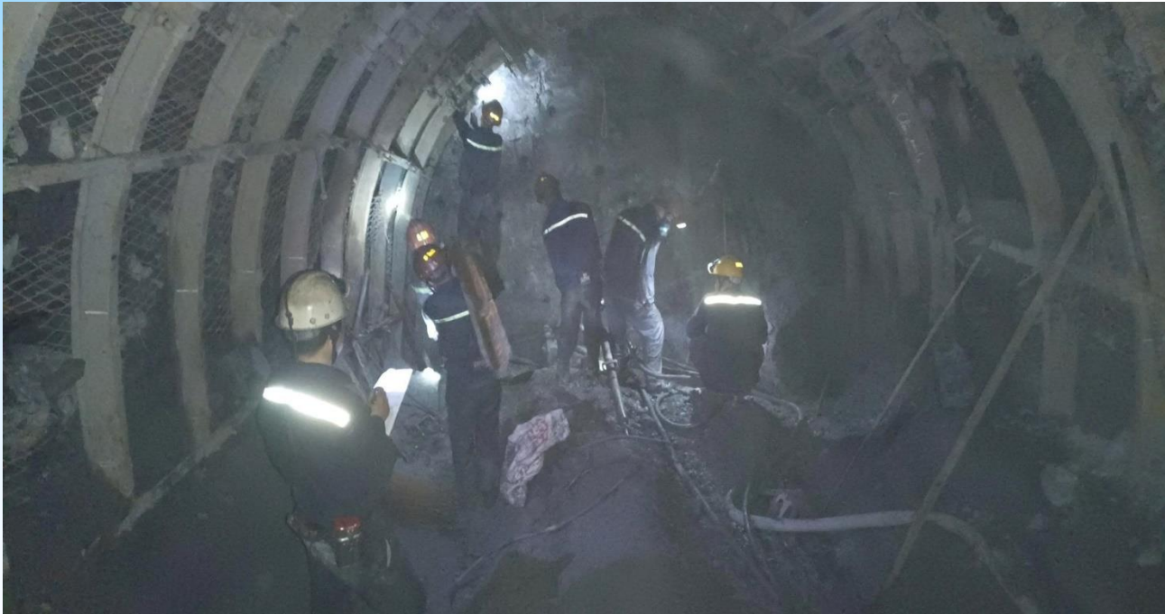
Hình 1.11. Công tác khoan lỗ mìn trên gương
