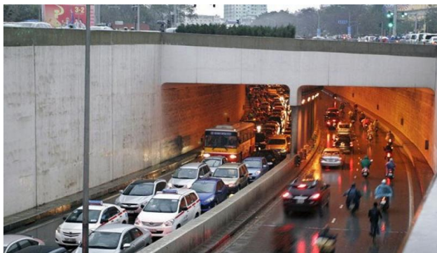
Hình 1.20. Hầm đường bộ Kim liên
