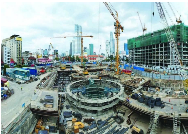
Hình 1.25. Nhà ga Metro Trung Tâm Bến Thành (TP. Hồ Chí Minh)
