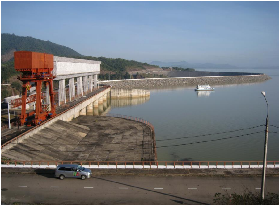
Hình 4.1. Toàn cảnh nhà máy thủy điện Yaly
