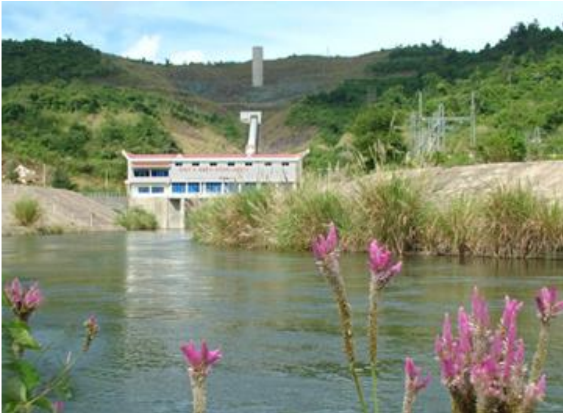
Hình 1.2. Tháp điều áp, ống áp lực và nhà máy công trình thủy điện
