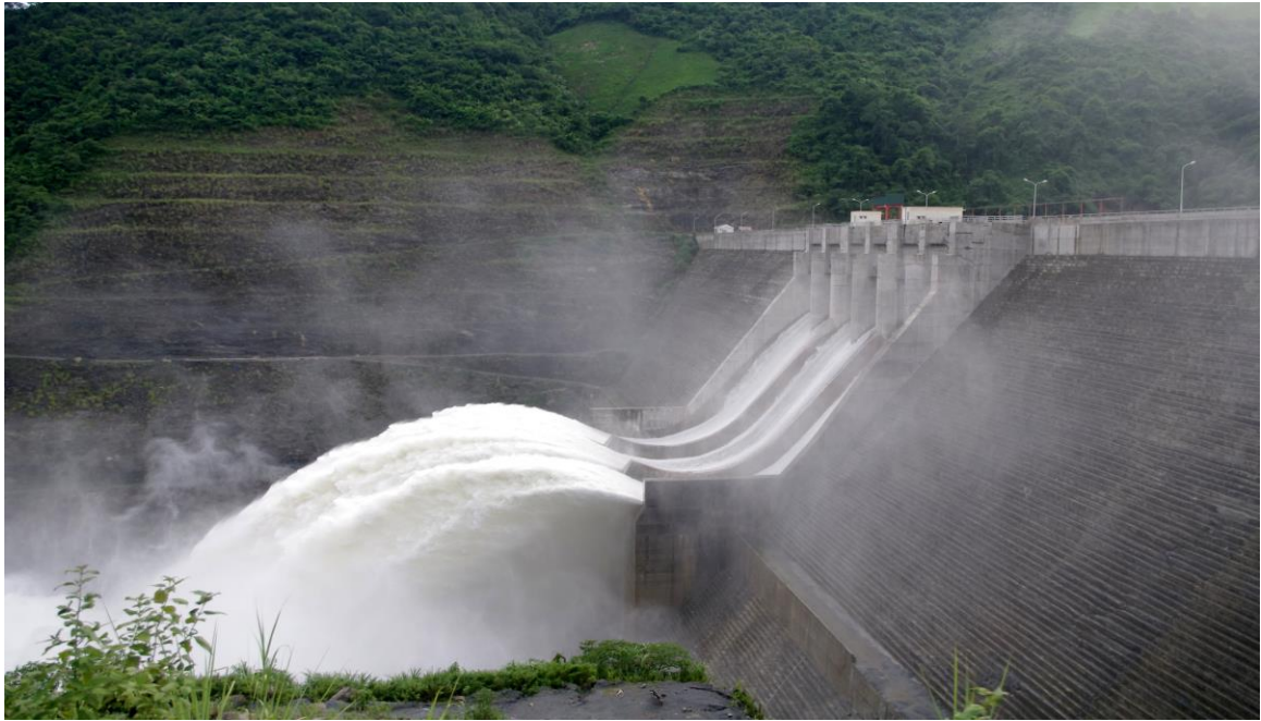
Hình 1.1. Đập dâng và tràn công trình thủy điện
